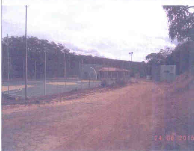
Via de acesso/saída ao estacionamento.
