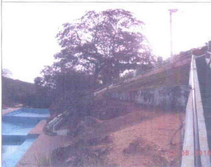
Os acessos (via escadas) do Balneário com as instalações de Apoio.
