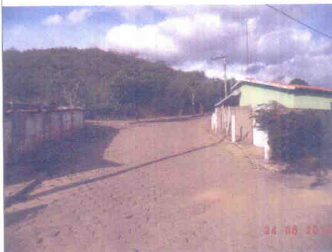
Vista geral da via principal (Chico Caveira) pela via secundária (Chico Ferreira).
