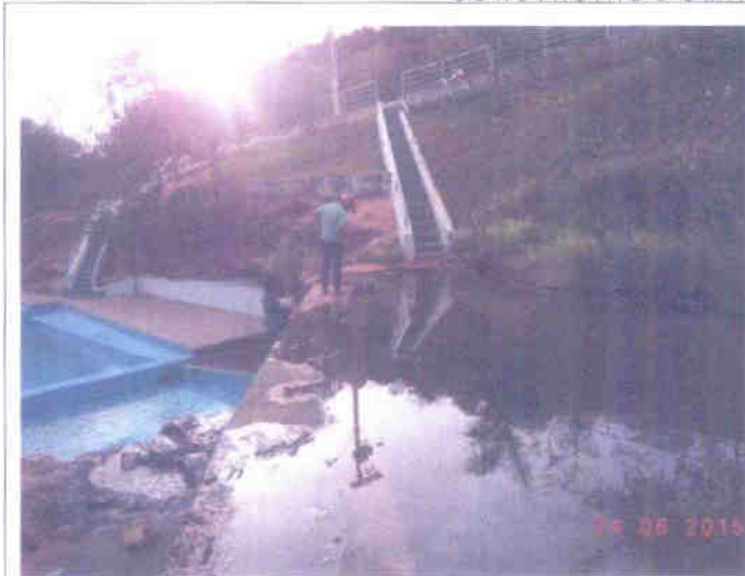
Barragem que atende as piscinas.
