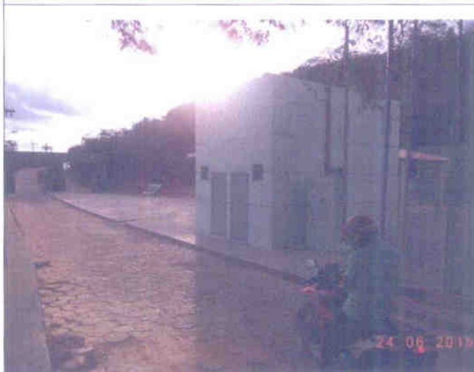
Vista geral do restaurante/lanchonete/área de alimentação e do pórtico de entrada.
